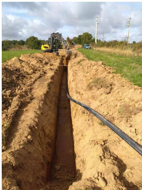
Dans la continuité du chantier de la Fernault, le SEA a également sollicité l'aide de l'Agence de l'Eau pour renouveler la conduite d'eau potable allant du secteur de la Bodeterie et traversant la Gadonne car bien qu'initialement non répertorié dans le schéma directeur de 2020, c'est l'enchaînement de fuites depuis cette date qui a orienté la décision de faire les travaux à cet endroit.
