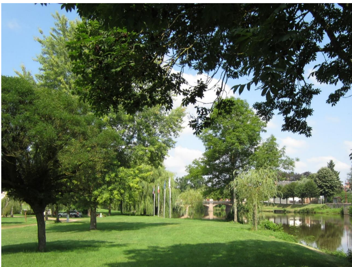
Les arches du pont sur la RD 2144 vues de l'ancien camping
