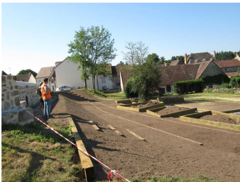
Travaux au jardin de la cure
